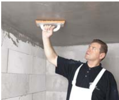
Po zavädnutí sa povrch upraví navlhčeným špongiovým hladidlom točitým pohybom
