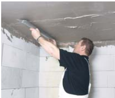
Nanesená vrstva Rimana sa vyrovná „H“ latou v jednom smere
