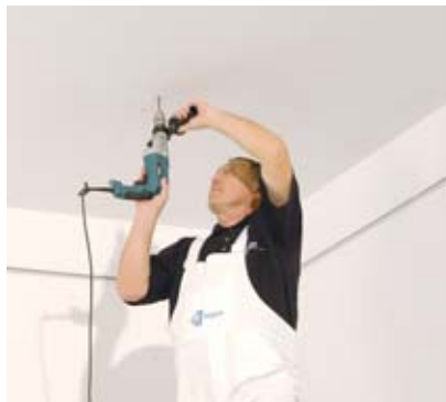
Kotvenie závesov do nosného stropu
