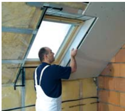
Vloženie dosky pre bočné ostenie do drážky v ráme okna
