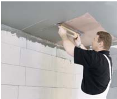
Aplikácia Rimana na betónový strop natretý kontaktným náterom
