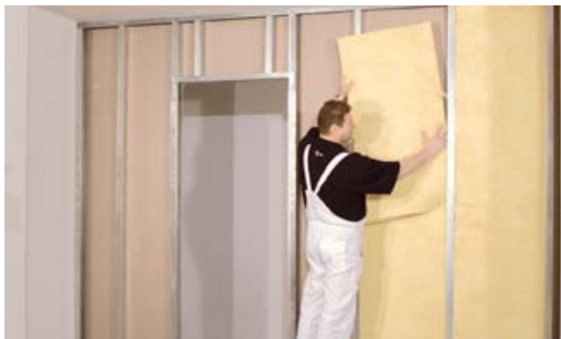
Vloženie minerálnej izolácie do dutiny priečky
