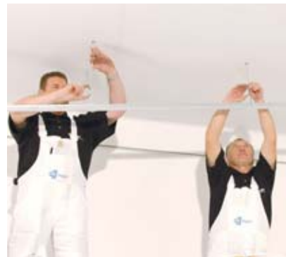
Osadenie nosných T-profilov
