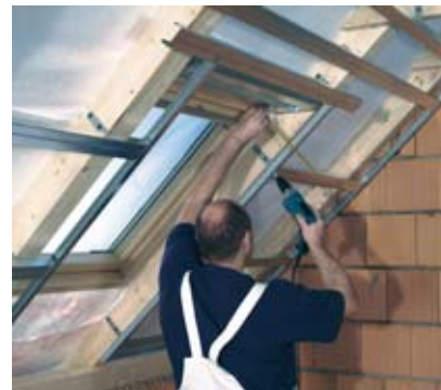
Montáž podkonštrukcie, UD a CD profily sa spoja samozávrtnými skrutkami typu LB
