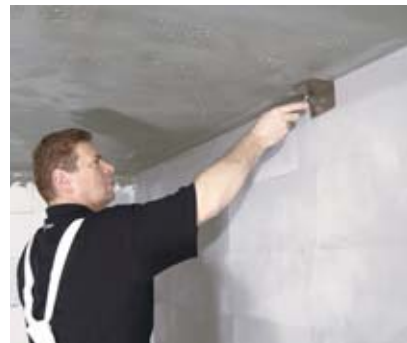
Vnútorne kúty miestnosti sa upravujú pomocou hladidla na rohy
