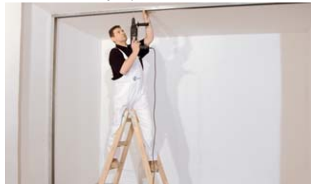
Montáž nosnej konštrukcie priečky – obvodové profily UW
