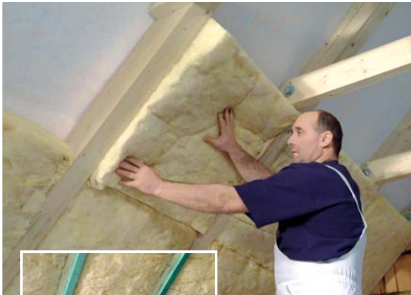
Vkladanie tepelnej izolácie
