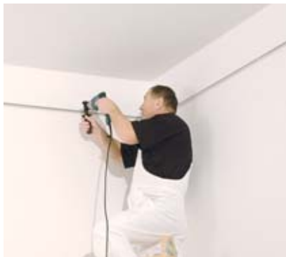
Montáž obvodových profilov
