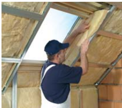
Osadenie tepelnej izolácie
