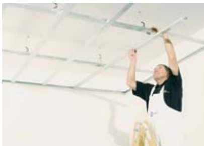
Montáž nosných a montážnych profilov krížového dvojúrovňového roštu
