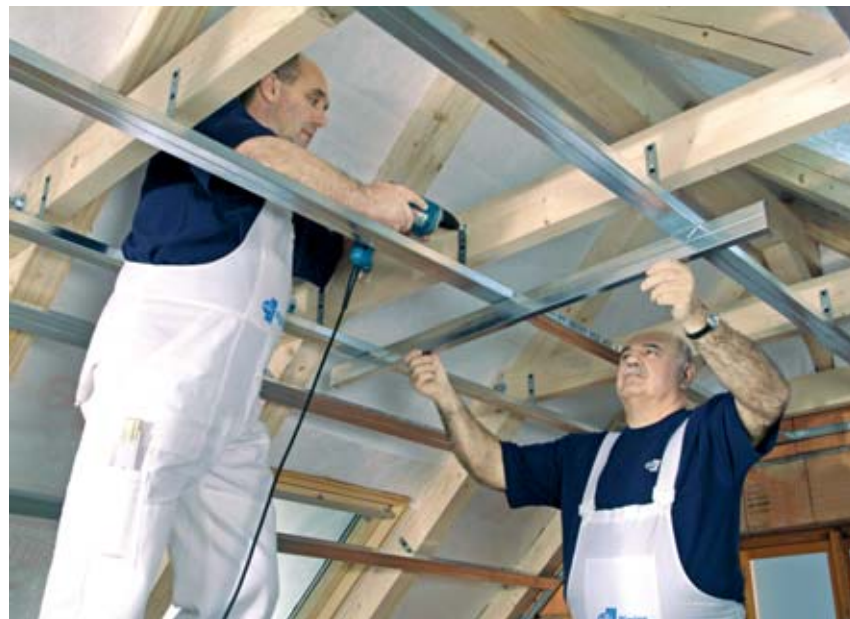
Montáž podkonštrukcie – pripevnenie pomocou krokvových závesov
