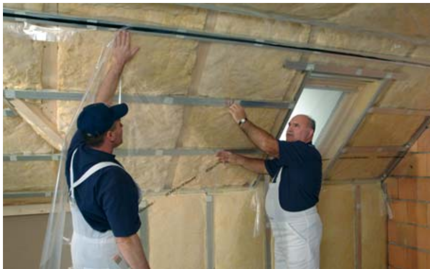
Inštalácia parozábrany – parozábrana na podkonštrukcii
