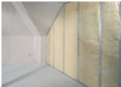
Vloženie minerálnej izolácie
