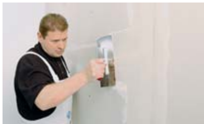
Rozťahnutie a uhladenie tmelu.
