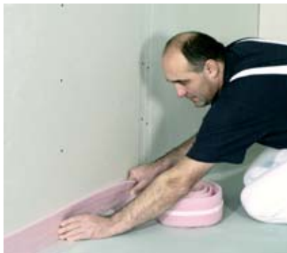
Pripevnenie okrajových pásiikov
