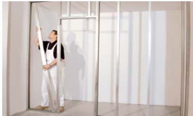
Montáž nosnej konštrukcie priečky – zvislé profily CW
