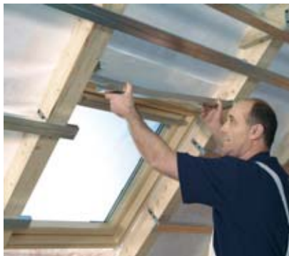
Vloženie CD profilu do UD profilu v nadpraží okna
