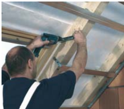
Priskrutkovanie UD profilu na krokvu
