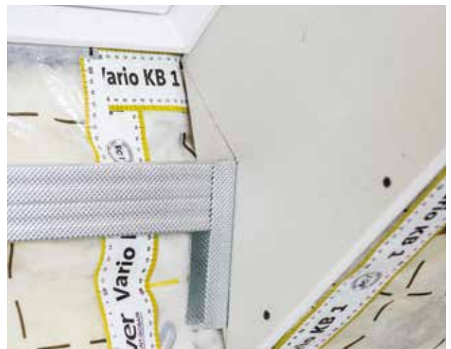
Rovnaké zásady platia i na montáž podkonštrukcie nadpražia i parapetu.
