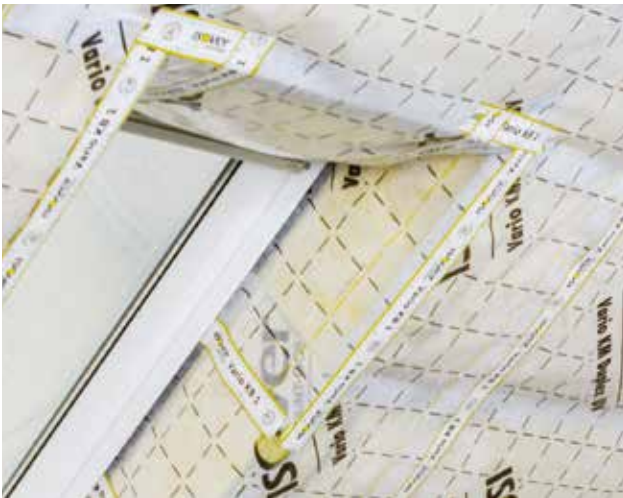
Aplikácia parozábrany (v oblasti strešného okna parozábranu prerezať v tvare písmena „J“)
