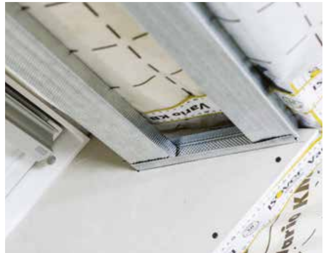
R-UD profily pripevnené z rubovej strany dosky dvoma skrutkami typu TN 25 mm, v nich osadené R-CD profily
