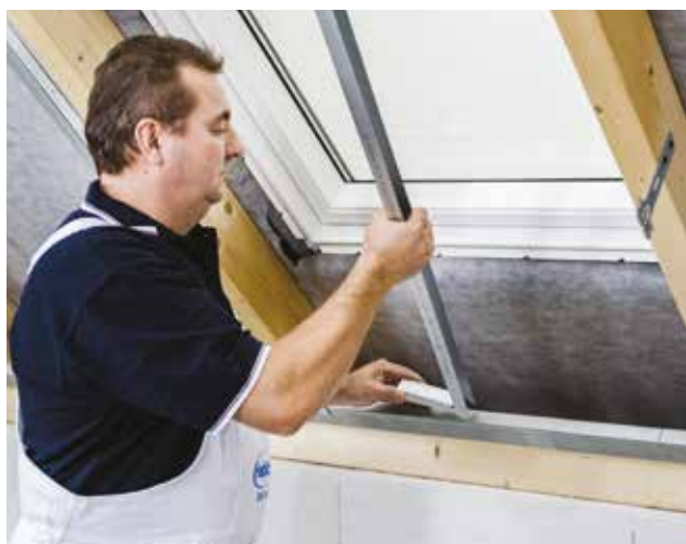
Výmena z R-UD profilov nasunutá medzi spodný a vrchný R-CD profil
