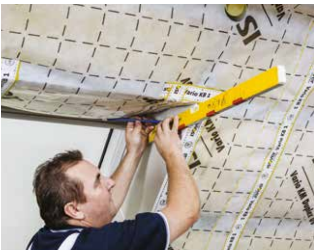
Rozmeranie zalomeného nadpražia a parapetu pomocou uholníka...
