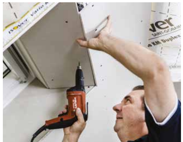
Zalomenie nadpražia a parapetu narezaním lícového kartónu a pripevnené skrutkami typu TN 25 mm
