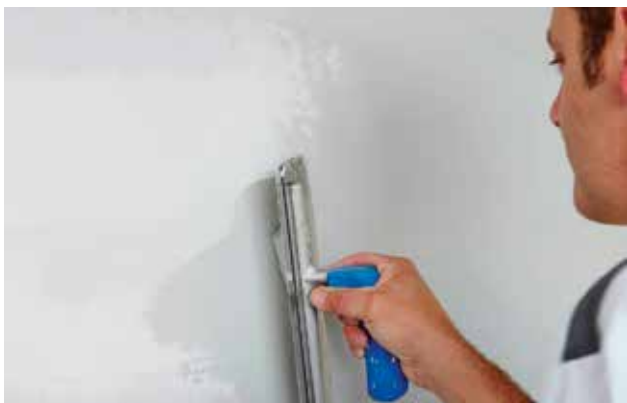
Rozťahnutie a uhladenie tmelu
