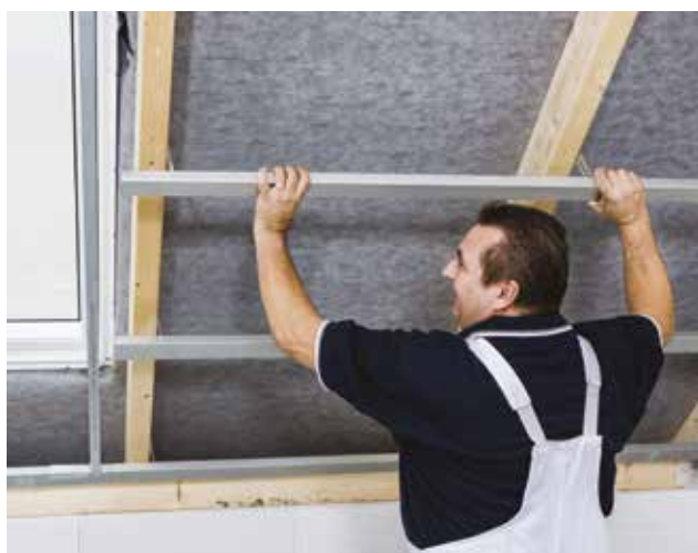
Montáž podkonštrukcie z R-CD a R-UD profilov
