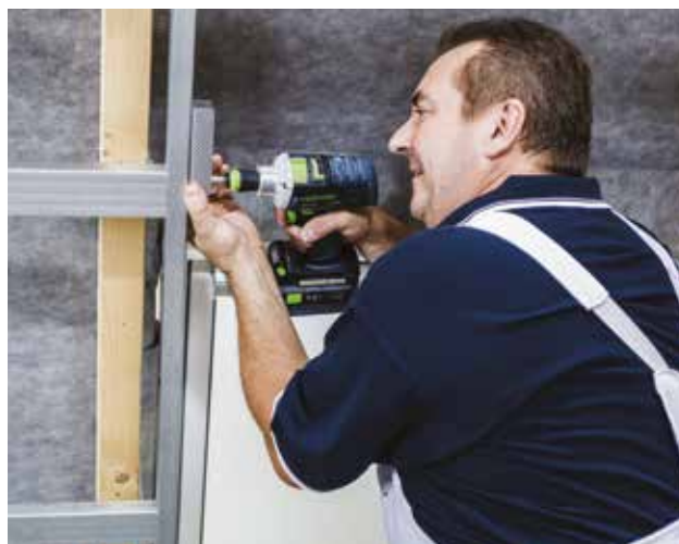
Vytvorenie pomocnej konštrukcie z R-UD profilov vrátane osadenia R-CD profilov (zaistenie dvomi skrutkami LB)
