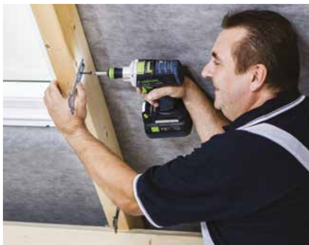
Pripevnenie závesov do drevených krokiev
