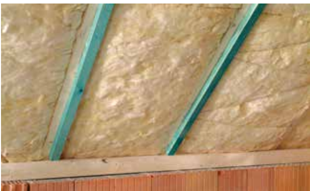
Vkladanie tepelnej izolácie a predsadené laty na krokvách
