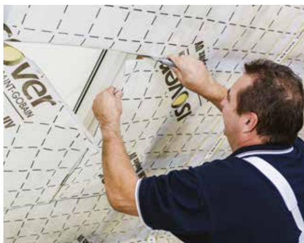
Aplikácia parozábrany (v oblasti strešného okna parozábranu prerezať v tvare písmena „I“)
