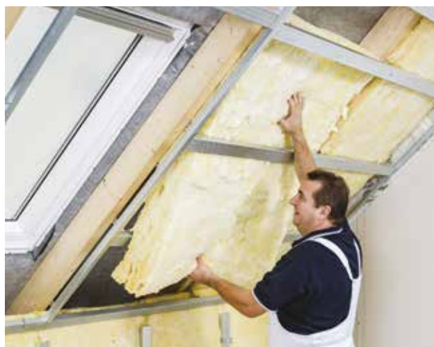
Vloženie minerálnej izolácie
