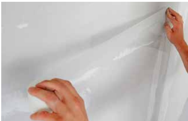
Aplikácia sklotextilnej pásy
