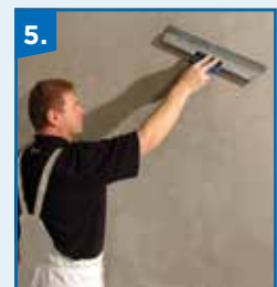
5. Aplikácia a vyhladenie finálnej vrstvy Rimano Glet XL
