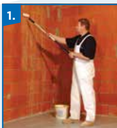
1. Penetrácia podkladu Rikombi Grund alebo Rikombi Kontakt
