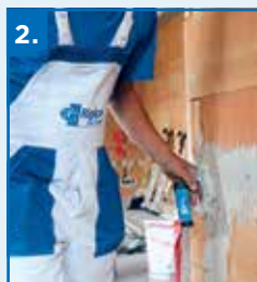
2. Upravenie rozvodov elektriny a vody, upravenie špaliet použitím Rimano Multi
