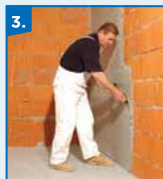
3. Aplikácia celoplošnej podkladovej vrstvy Rimano Multi
